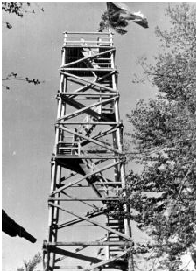
Razgledni stolp na Planini nad Vrhniko, izveden kot lesena konstrukcija iz hrastove lesa višine 21 m, slikan na dan otvoritve 22. 5. 1955.
