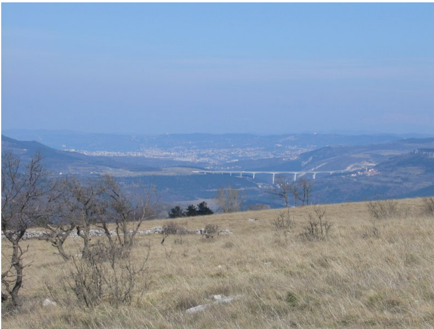
Viadukt Črni kal
